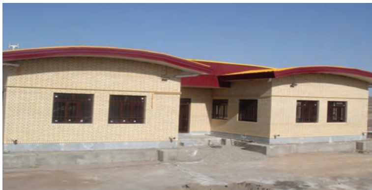
شکل ۳۲ - نمایی از یک راهدارخانه
